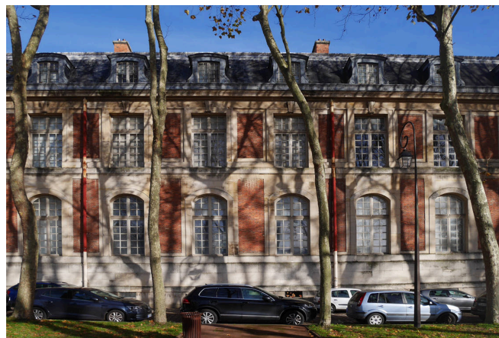
Figure 14: Effets d'ombrage sur façade. Photographie prise au 5 avenue de Sceaux, le 24 novembre 2022.
