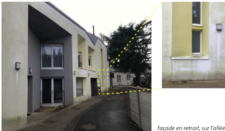
façade en retrait, sur l'allée
